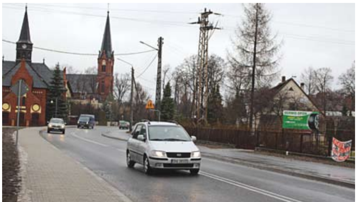
Fragment zmodernizowanej drogi w miejscowości Kup.
